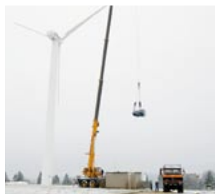
Reparatur in 45 Meter Höhe.
