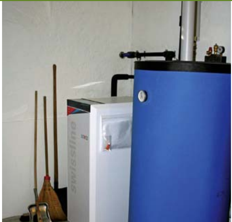
KWT Wärmepumpe Swisline für Einfamilienhäuser – halb so gross wie eine Waschmaschine
