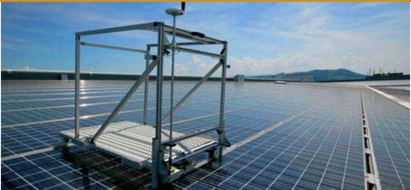
Inspektion der Solarzellen auf dem Stade de Suisse mit der SolarDraisine®
