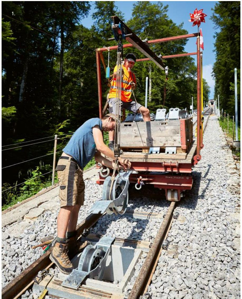
1. 1'600 m<sup>3</sup> Schotter, 1'900 Schwellen und 3,5 Kilometer Schienen sind verlegt, nun müssen alle 12 Meter die Seilführungsrollen eingebaut werden. Dabei kommt ein Montagewagen zum Einsatz.
