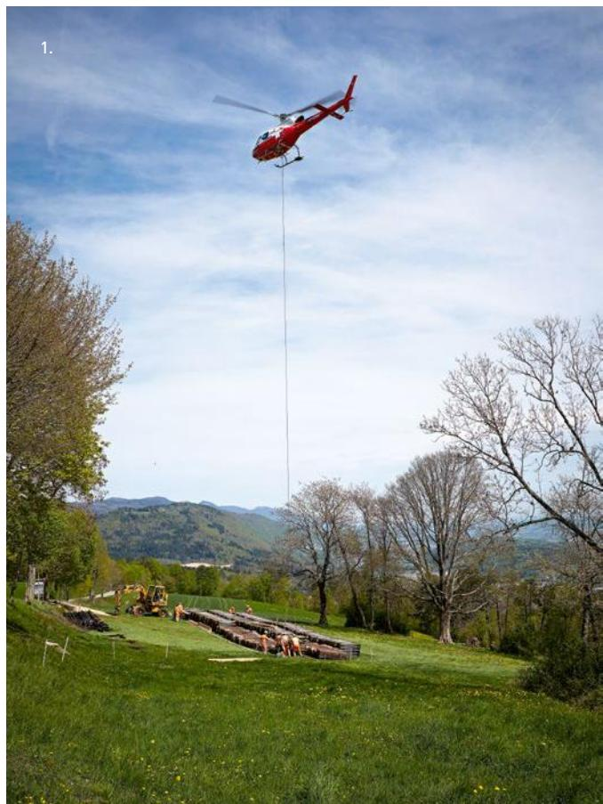
1. Sowohl für den Abtransport wie auch fürs Anliefern der Schienen und Schwellen kommt ein Helikopter zum Einsatz. Pro Flug kann er 19 Schwellen oder 2 Schienen à 12 Meter Länge transportieren. Der Umschlagplatz befindet sich einige hundert Meter Richtung Leubringen.
