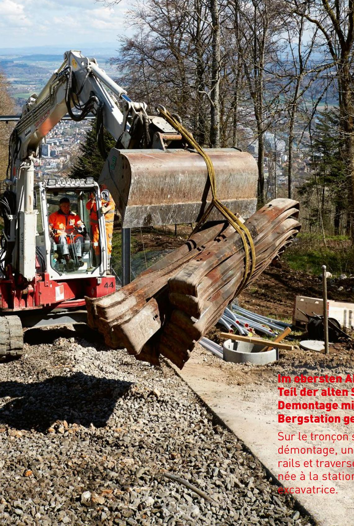
**Im obersten Abschnitt kann ein Teil der alten Schwellen nach der Demontage mit dem Bagger zur Bergstation gebracht werden.**
