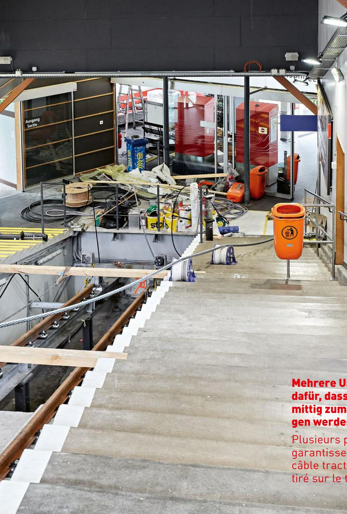
**Mehrere Umlenkrollen sorgen dafür, dass das neue Zugseil mittig zum Trassee hochgezogen werden kann.**
