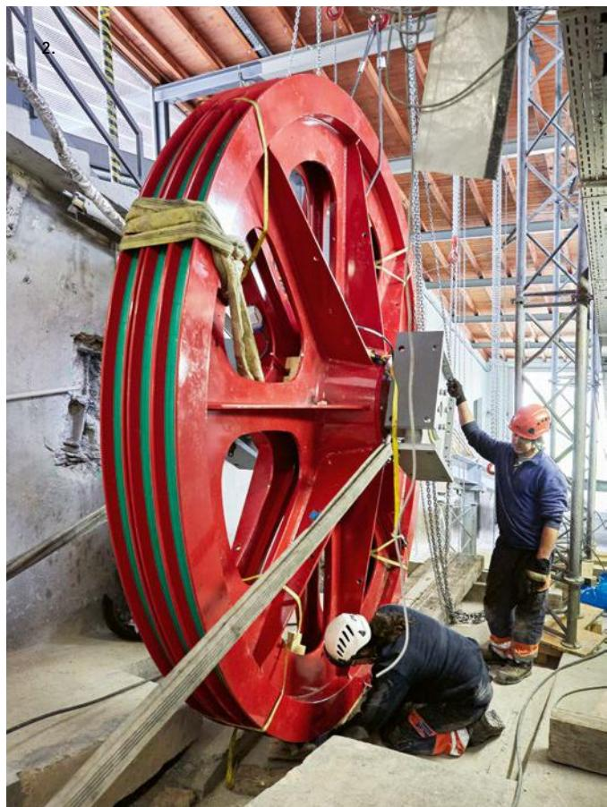
1. Mittels Winde wird die dreirillige Gegenscheibe Zentimeter für Zentimeter in Position gebracht.
