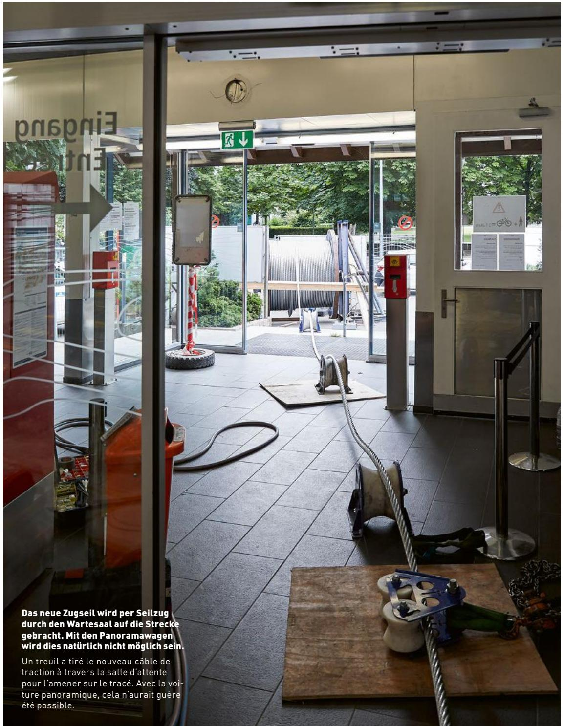
**Das neue Zugseil wird per Seilzug durch den Wartesaal auf die Strecke gebracht. Mit den Panoramawagen wird dies natürlich nicht möglich sein.**
