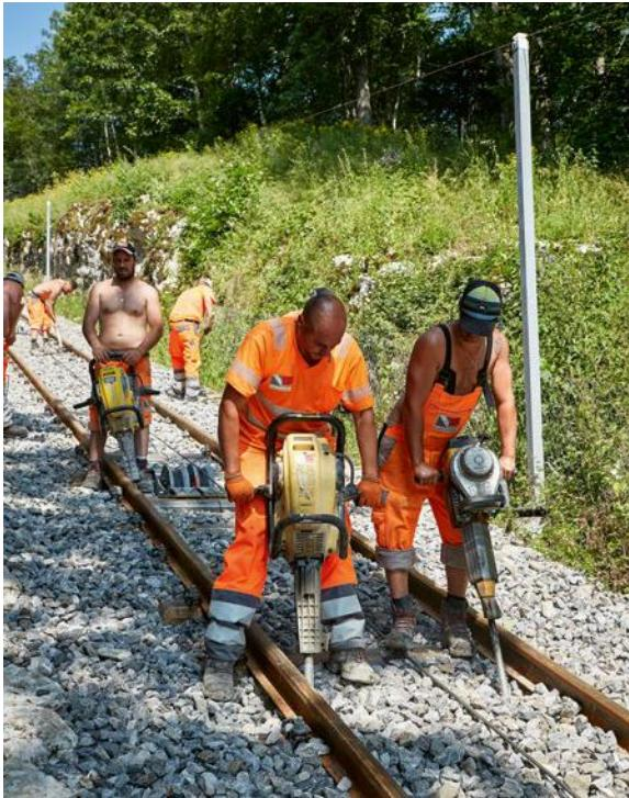
**Stabilität ist gefragt: Damit sich das Trassee – und damit das Geleise – nicht mehr verschiebt, wird der Schotter verdichtet. In der hochsommerlichen Hitze eine schweißtreibende Arbeit. Ebenfalls zu sehen ist der Montagewagen, auf dem sich die Seiltrollen befinden, die gleichzeitig montiert werden.**
