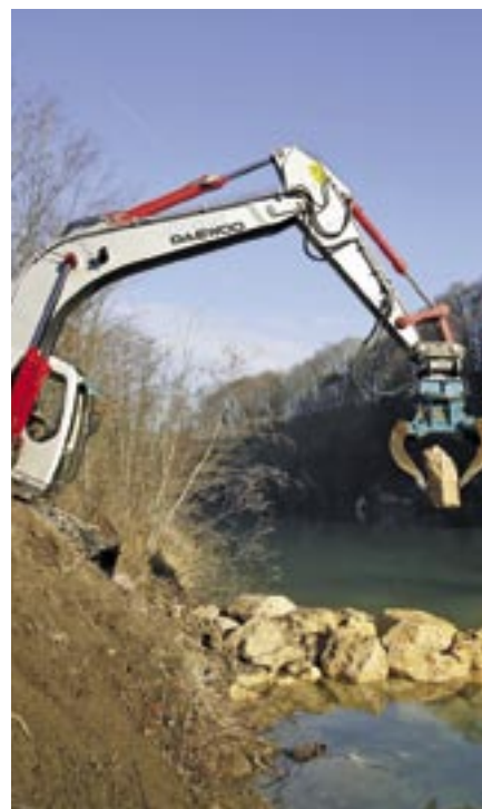
Bagger setzt Blockbuhnen
