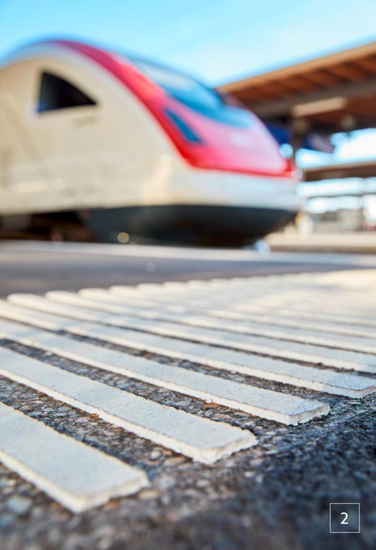
*„Die taktil-visuellen Markierungen dienen nicht nur Blinden, indem sie mit dem Blindenstock gut ertastet werden können, sondern auch Menschen mit Sehbehinderungen, weil sie einen Kontrast zum umgebenden Boden aufweisen.“*
