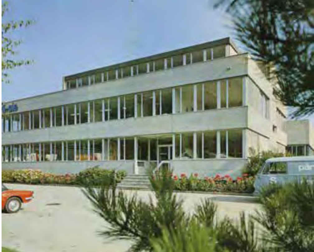
Der Neubau an der Renferstrasse, 1965 feierlich eröffnet.
