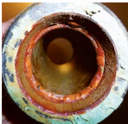
36 Monate nach der Installation von Aqua4D®
